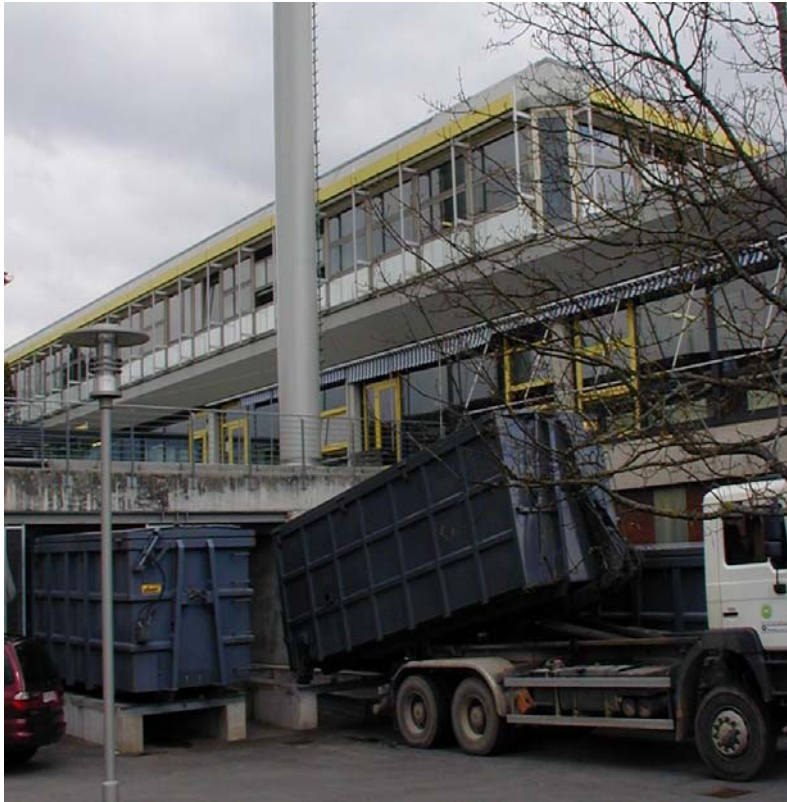
Abbildung 2: Anlieferung von Holzhackschnitzeln zur sanierten Heizzentrale in Herrenberg
